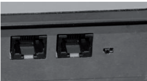
Afsluitweerstand RCC-03 geactiveerd (links)
